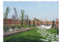
堺市業務施設の屋上緑化の実例
