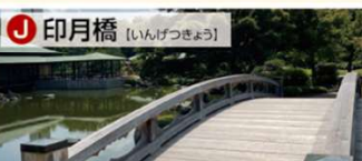
J 印月橋 [いんげつきやう] 映波橋と同じく池泉の中島に架かる反橋が印月橋です。橋からは四季折々の風情を流し流されるさざ波の様子や水面に浮かぶ美しい景色を楽しむことができます。
